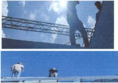
Foto1: Desinstalación de soporte de techo de metal por oxidación en modulo 1
