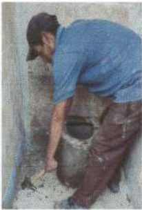
Foto 3: desinstalación de inodoros por el mal estado
