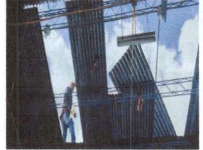
Foto 2: desinstalación de lámina oxidada y filtración de agua en modulo 1
