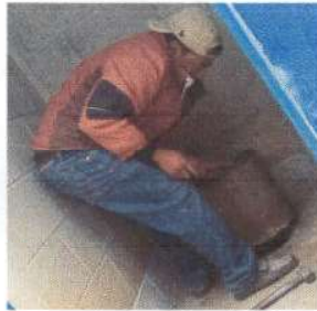
Foto 3: desinstalación de inodoros por el mal estado
